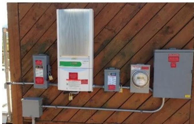
Figure 14 : Le système PV raccordé aux réseaux[43]
