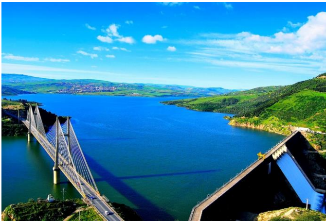
Figure 6 : vue sur barrage BH (El Watan).2025
