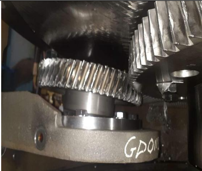
Figure 2. 9 Endommagement de l'arbre
