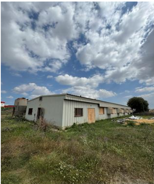
Figure 04 vue extérieure de bâtiment
