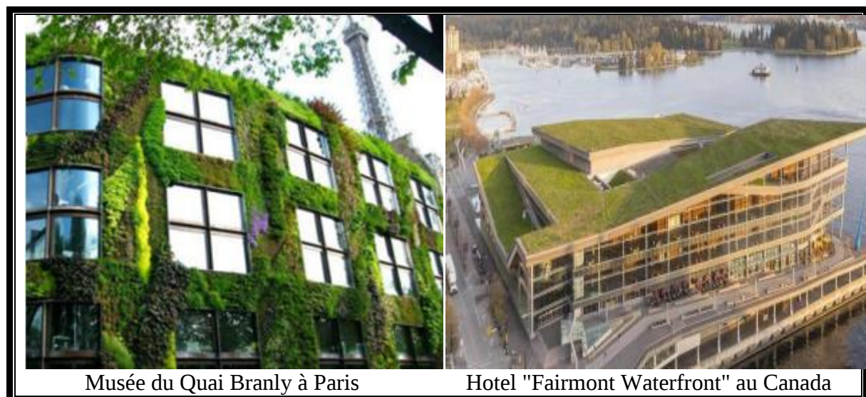
Figure 1. 21. Images d'une façade et d'une toiture végétales
