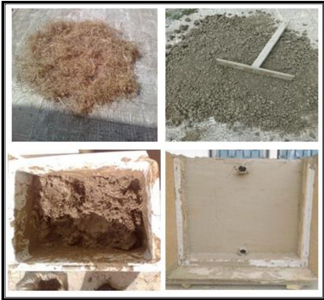
Figure 5. 3. Etapes de l'élaboration du mur Trombe
