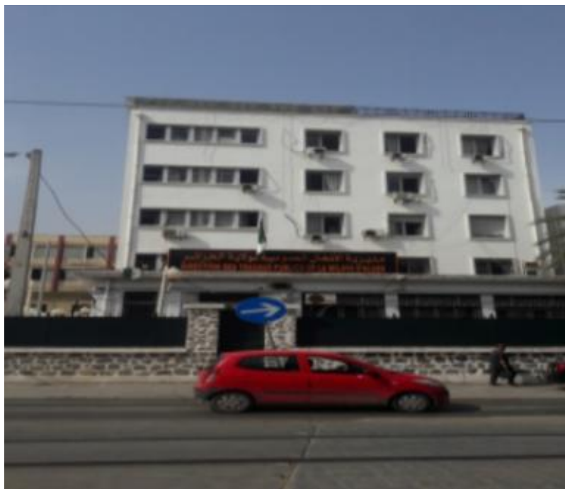
Figure 1 : Siège de la direction des travaux publics Alger
