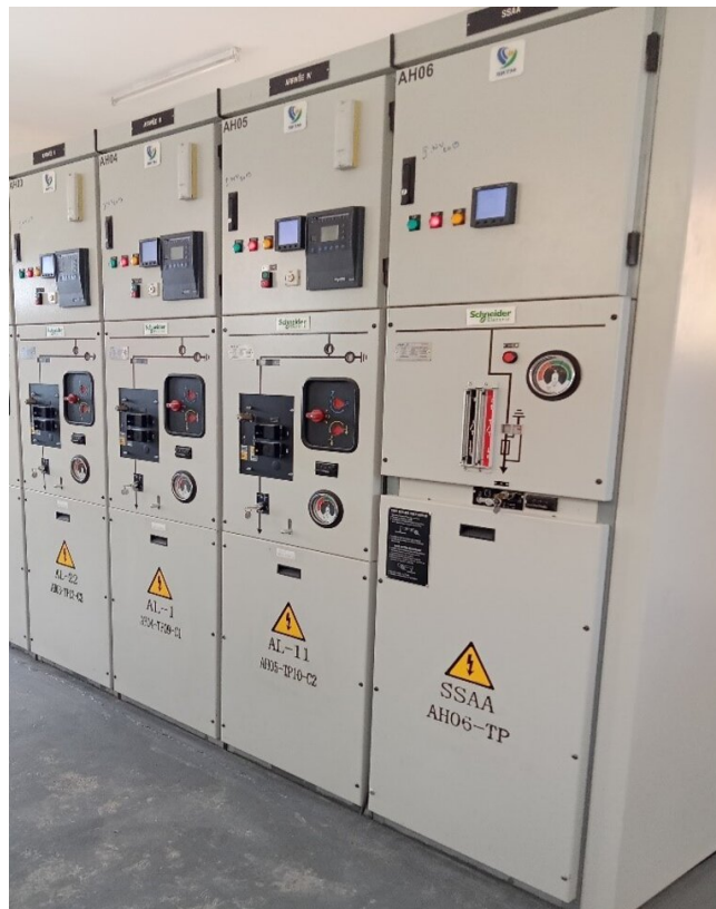
Figure 3.12: «CMBGS-0» MV cell
