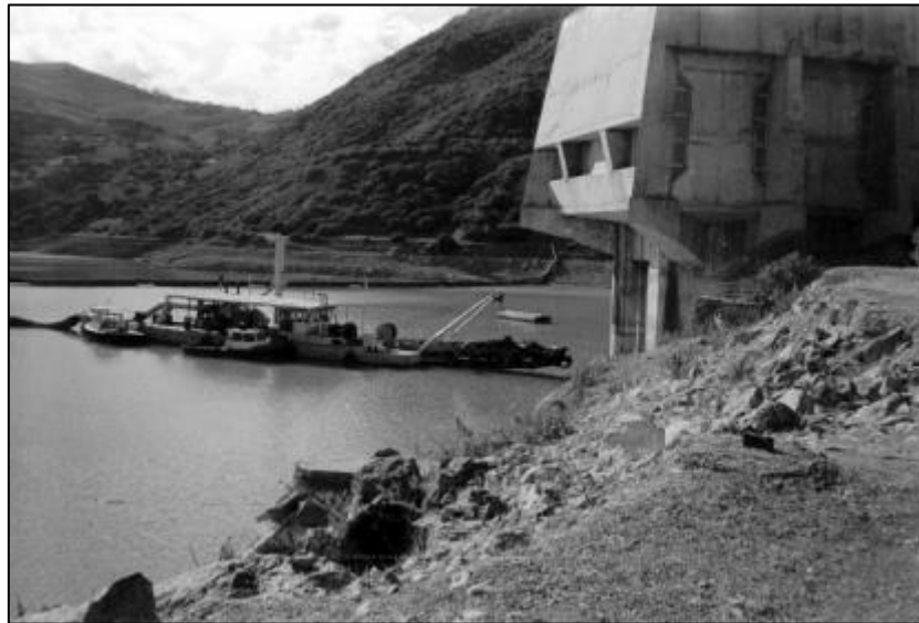
Figure 1.8. Dragage suceuse- refouleuse Rezoug Youcef au cours du dévasement de la retenue de Zardezas (Remini,1997)
