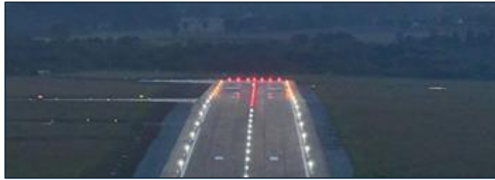
Figure 1 16: Balisage de l'extrémité de piste.
