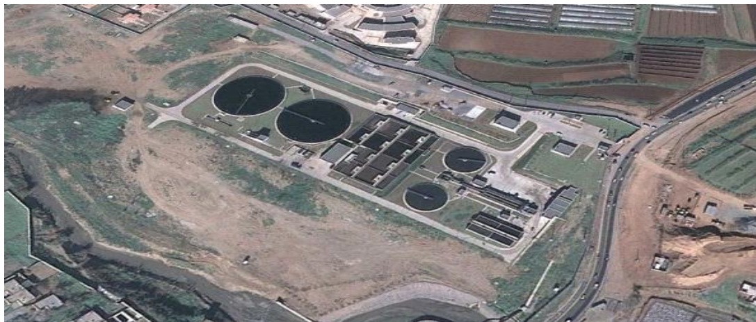
Figure III.1 : Vue d'ensemble de la STEP de Beni- Messouss [29].
