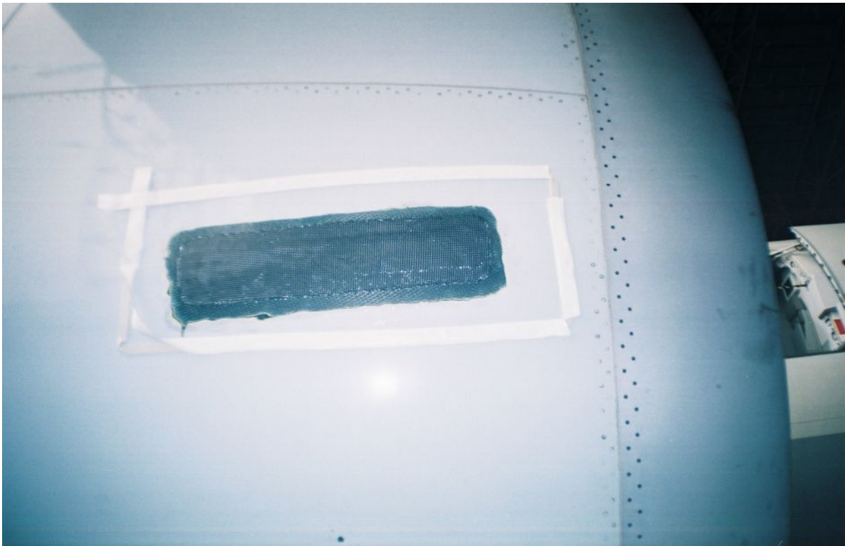
Figure (III-18) : Le remplissage.
