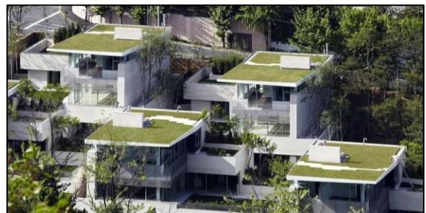
Fig. 34(II.3). Exemple des toitures végétalisées
