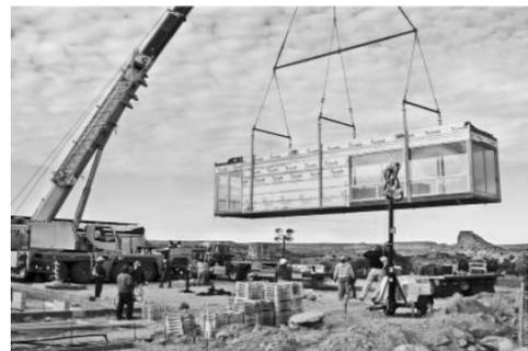
**Fig 54(III.5) : Structure modulaire préfabriquer**
