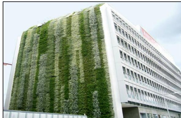
Fig. 38(II.3). Exemple d'un Mur végétal
