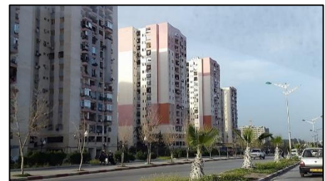
Fig.16.(III.1).Vois mécanique (inter quartier AADL / Src : photo prise parauteurs2017
