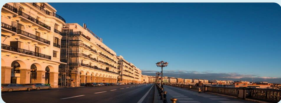
Figure 52: Sur La façade coloniale
