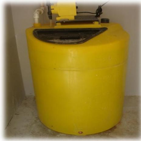
**Figure 2.10** Stockage de l'hypochlorite de sodium.
