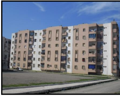
Fig 13 (I.3): l'habitat collectif. Src : auteurs 2017
