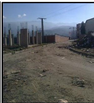
Fig47(I.4):Voie secondaire Src : Auteurs 2017
