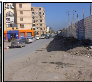
Fig 48(I.4) : Voie d'intervention Src : Auteurs 2017
