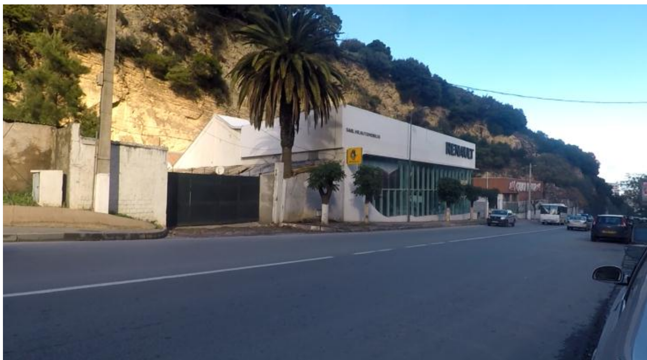
Photo. 23 : Bâtiment de Renault avec l'extension Source : Photo personnelle
