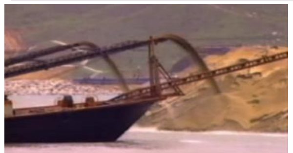
Étape 04: Utiliser le GPS pour repérer le point de refoulement(fig4)
