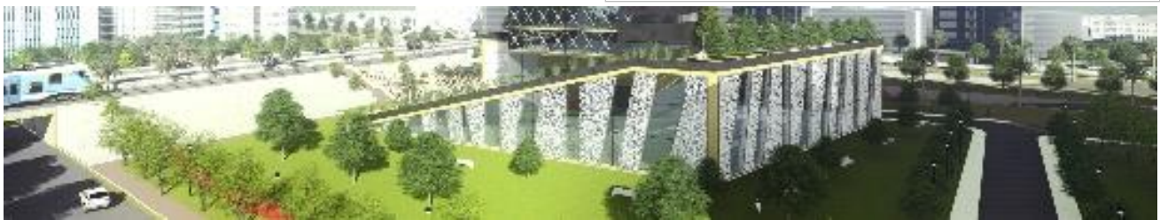
FIG : III.32 : Vue de socle Source : auteurs, 2017
