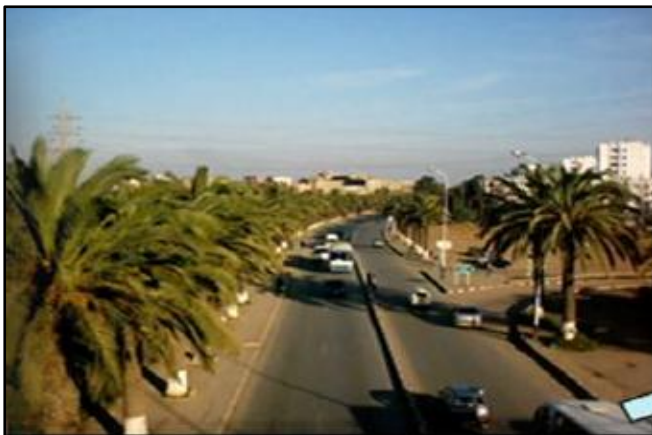
FIG III.10: La route nationale N5 La partie sud- nord Source : auteurs, 2017
