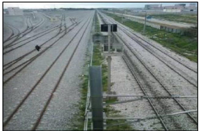
FIG III.8 : La voie ferrée Source : auteurs, 2017
