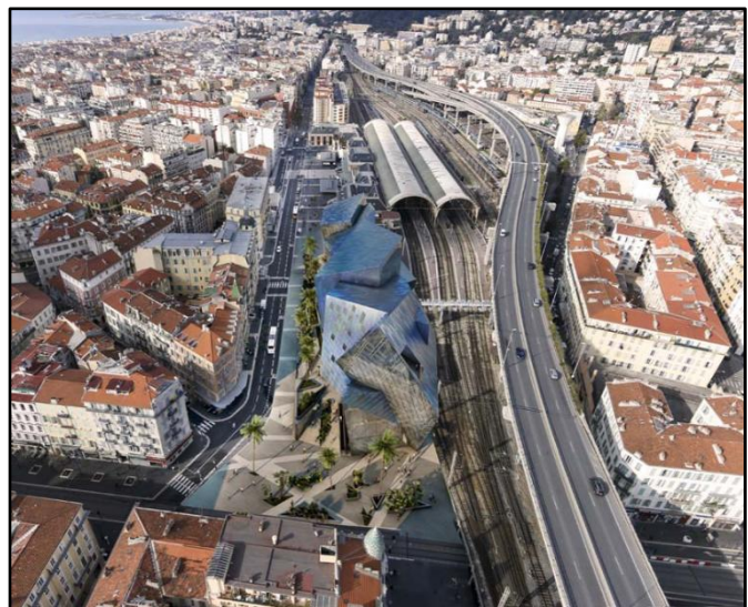
FIG II.5 : la coupure urbaine entre deux parties du centre-ville
