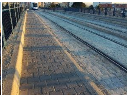
Fig.19 : Tramway Source : Auteurs
