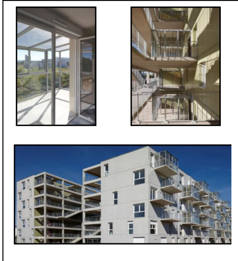
Fig40: Espace extérieur et intérieur du logement plateau de haye à Nancy Src: http://www.anma.fr
