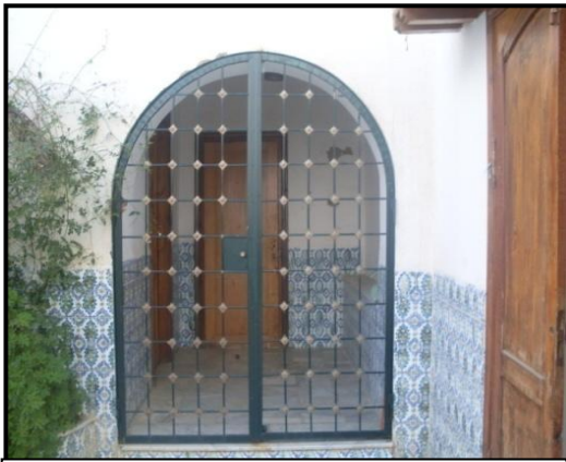
Arc plein cintre.
