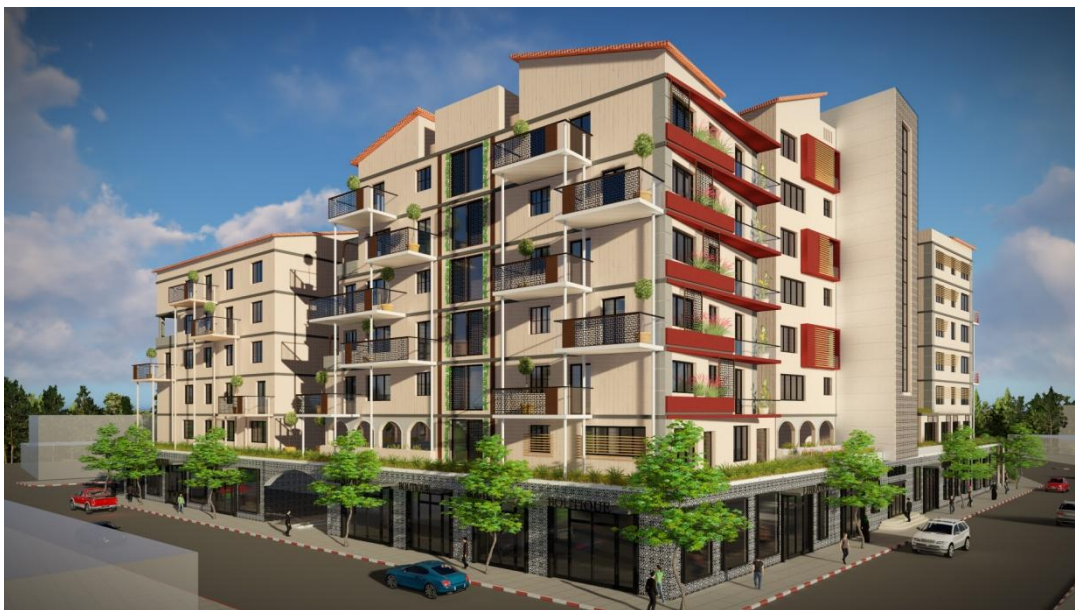
Fig125 : Vue sur la façade doit du projet Src: l'auteur
