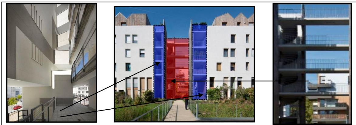
Fig44: Coursives et Passerelles de distributions dans le bâtiment Src: http://www.anma.fr
