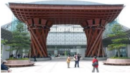
Figure III.17 : la gare ferroviaire de Kanazawa (Japon)
