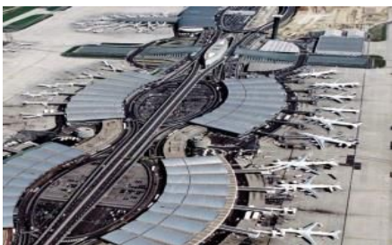
Figure III.19 : Aérogare de Roissy I
