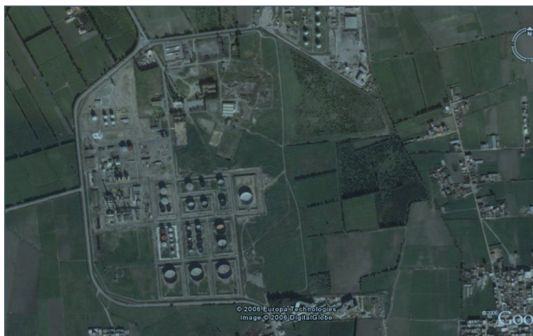
Figure I.1 : Vue aérienne de la Raffinerie d'Alger.
