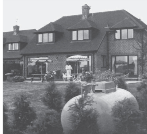
Figure III.5 : cuve de stockage de GPL pour une installation domestique.
