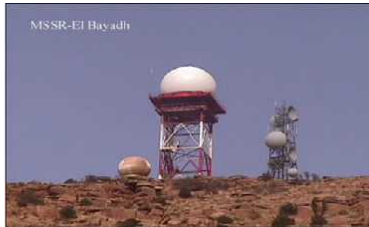
Figure II.1 Position de RADAR et des antennes
