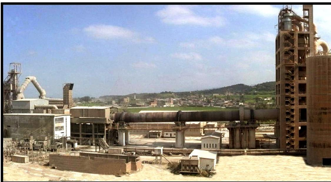
Figure I.11. Ligne de cuisson de la cimenterie de Meftah
