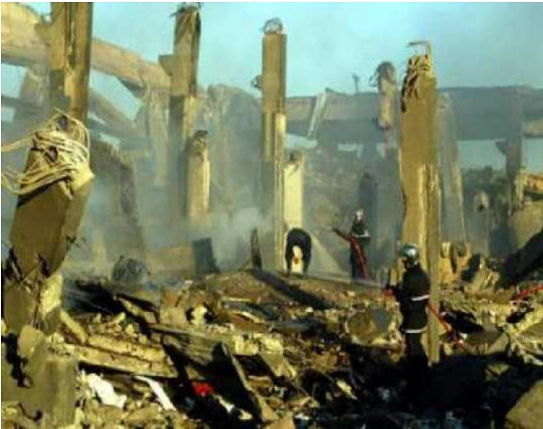
**Fig. I.9:** Explosion d'une chaudière de 70 bars et 375 t/h, le 19/01/2004 à 18h:40 au complexe GNL-SKIKDA-Algérie, l'accident a fait 27 morts et 74 blessés avec la destruction totale de la chaudière [34].
