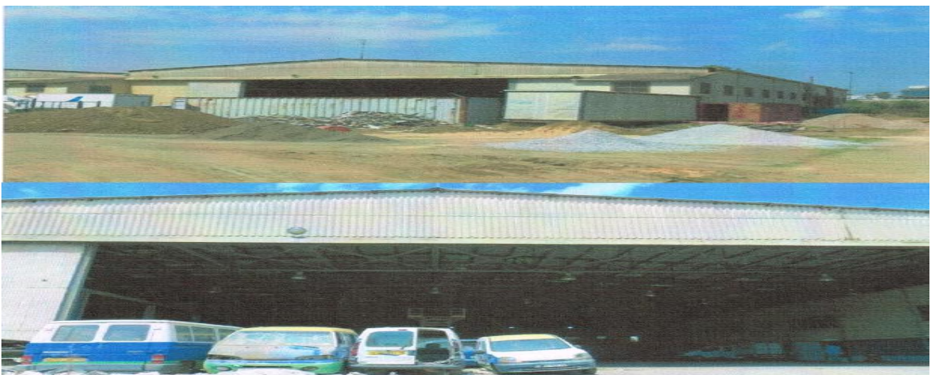
Figure IV.2: Vue extérieure d'hangar.
