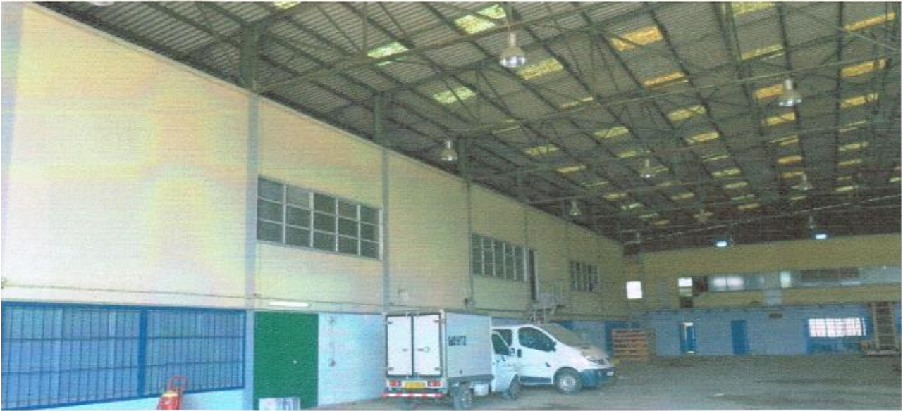
Figure IV.3: vue intérieure d'hangar
