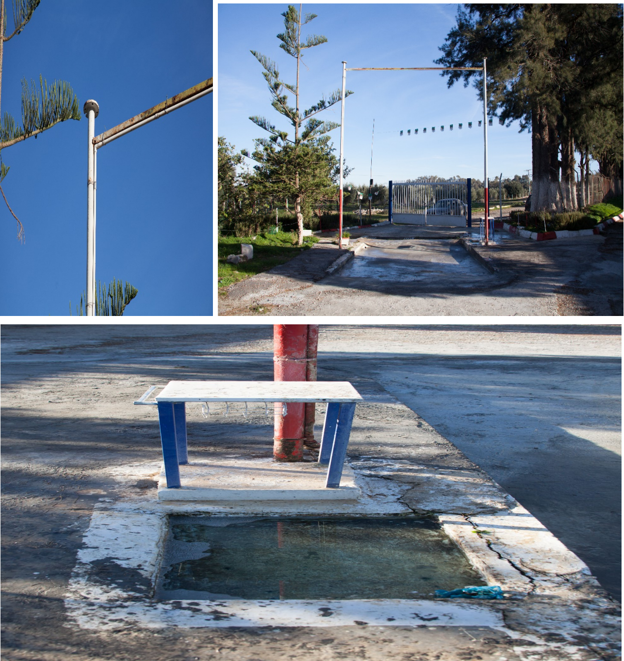
Photos 1 ,2 ,3 : Aspersion, rotolue, clôture et pédiluve.
