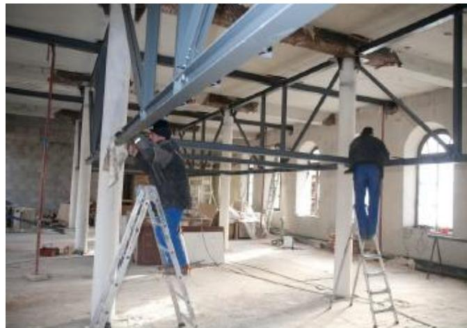
Figure 118 Vue sur les travaux de structure des lofts . Source : [www.domainedemontchal.com](http://www.domainedemontchal.com).
