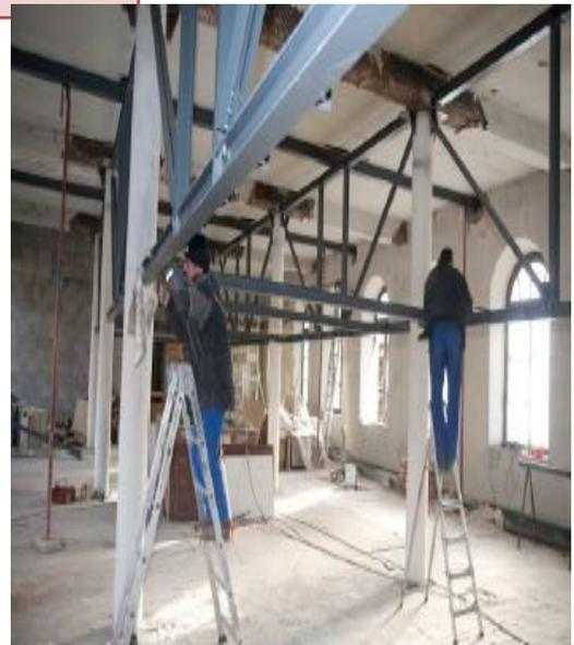
Figure 81 Nouvelle structure métallique ajoutée .
