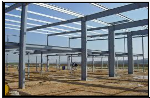
Photo.44 : STRUCTURE METALLIQUE Source : Google image
