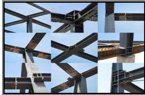
Photo.43 : STRUCTURE METALLIQUE Source : Google image
