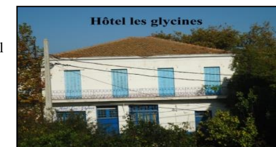
PHOTO 36 : PHOTO LES EQUIPEMENTS HOTEL Source : photo prise par auteur 12/2016
