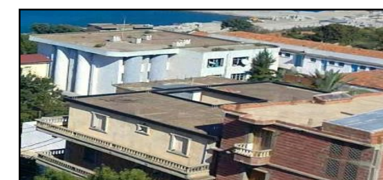
PHOTO 33: PHOTO D'HABITAT INDIVIDUEL Source photo prise par auteur 12/2016
