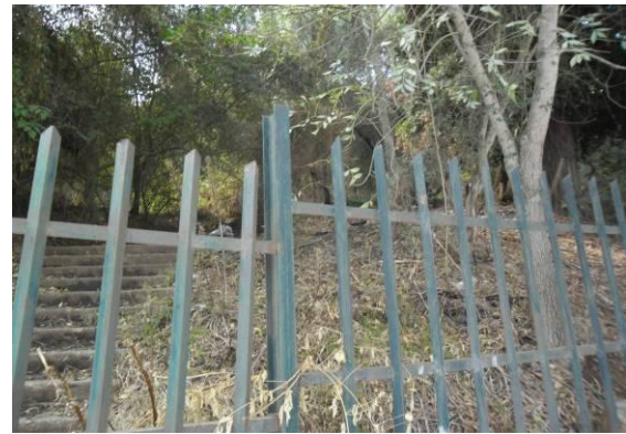
Figure 28 : Les barreaux installés à certains niveaux de l'arboretum
