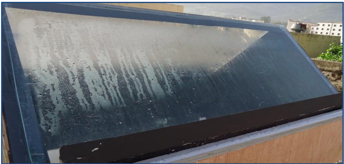
Figure III.8 : Photo montrant la couverture verrière.
