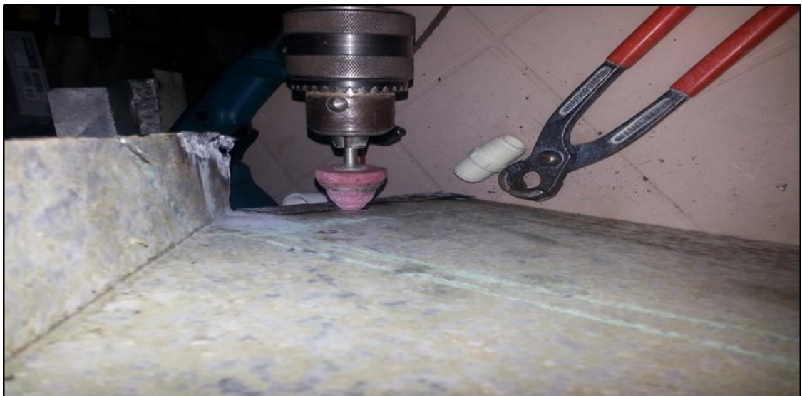
Figure III.3 : Photo montrant la construction des canaux.
