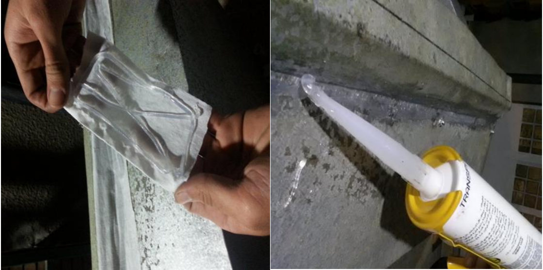
Figure III.4 : Photo montrant l'utilisation de la silicone.
