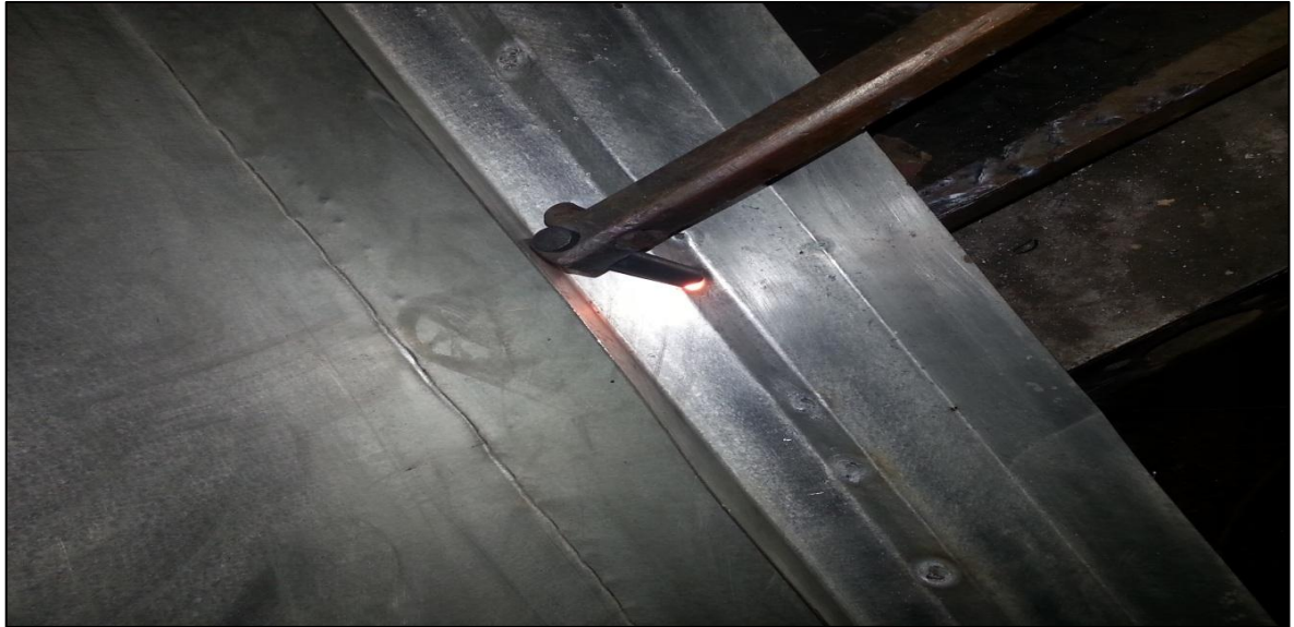
Figure III.2 : Photo de soudage par point des cotées et des gouttières.
