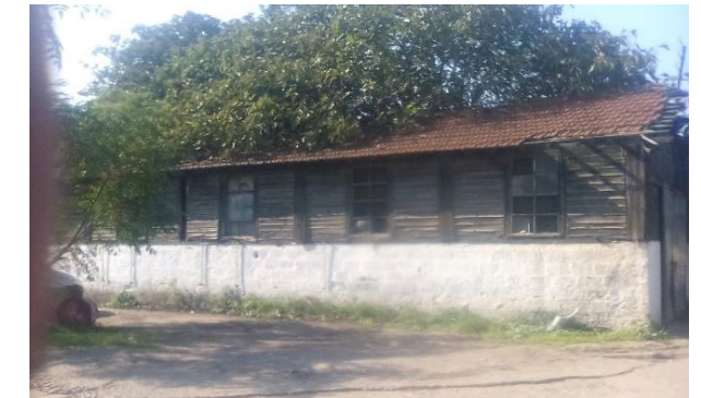
Figure 55: dépôt de sNTF, source : auteur
