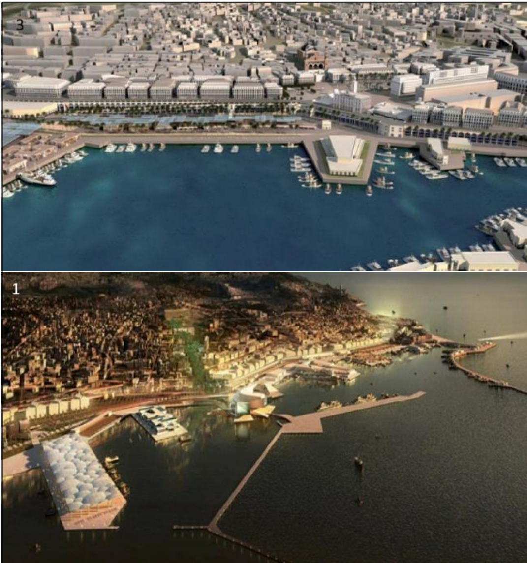
Figure 58: la reconversion du port d'Alger en espace culturel et de loisirs
