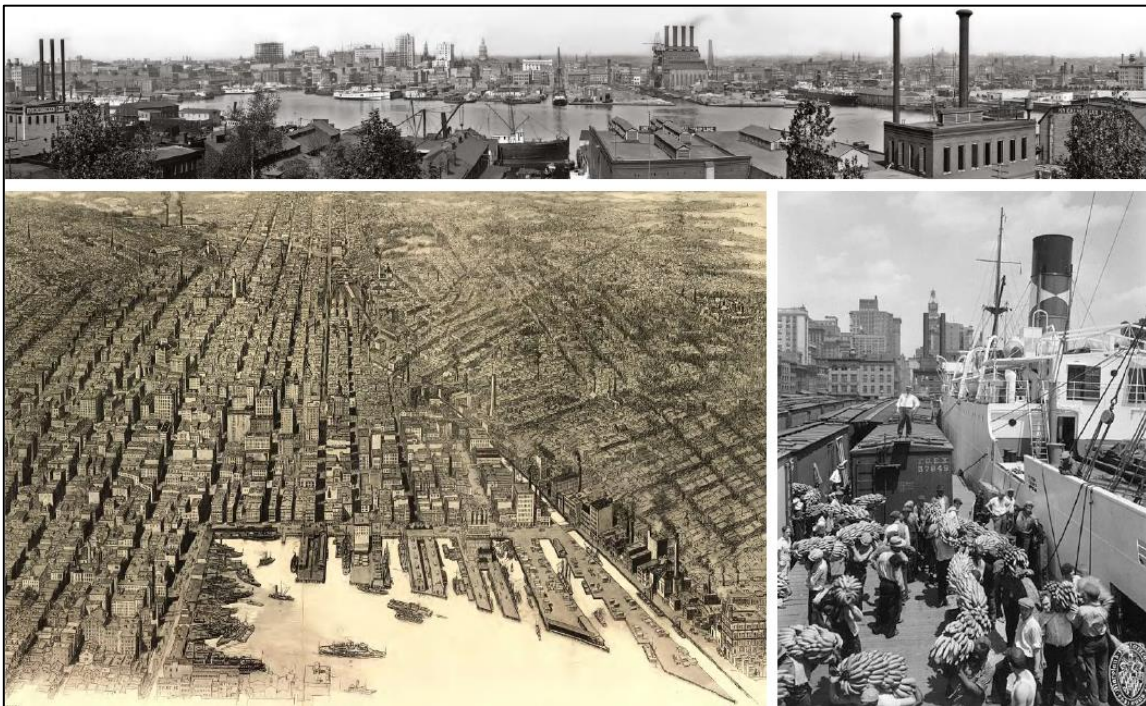
Figure 59: photos anciennes qui montre l'état de néfaste du port de Baltimore. Etats-unis
