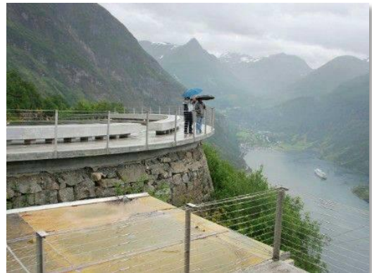
Un balcon surélevé
