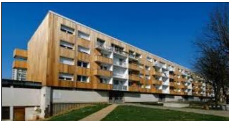
Figure 36 : l'utilisation du bois dans une construction à Saint Jean de Luz Le Rex. France
