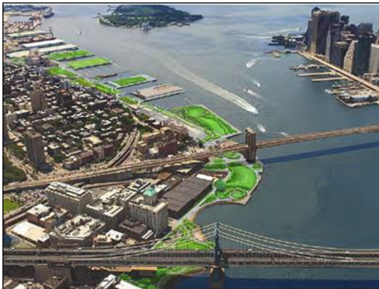
Figure 71 : nouvel aménagement de Brooklyn Bridge Park. Etats-Unis
