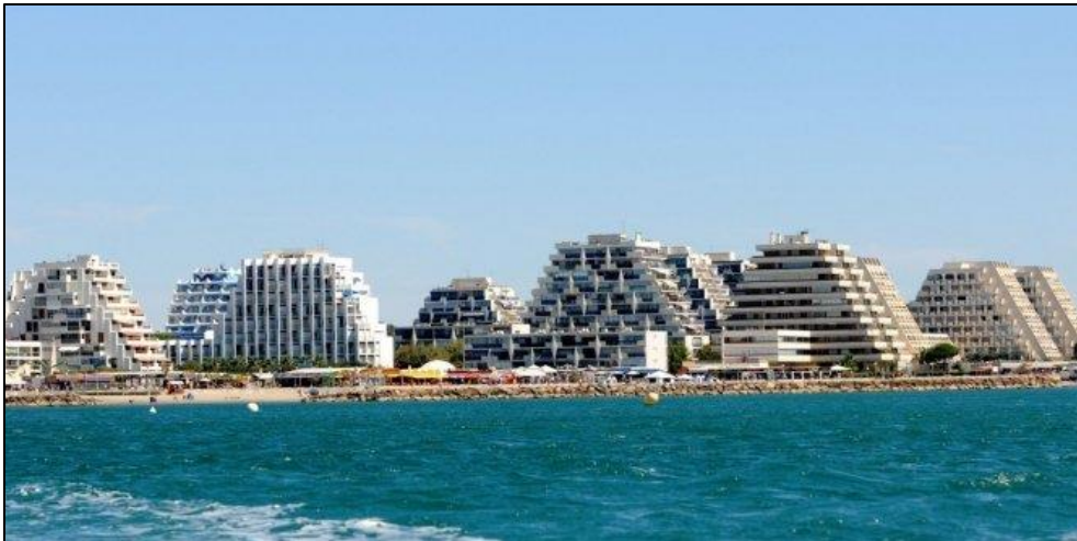
Figure 42 : aménagement des terrasses dégradées orientées vers la mer. La grande motte France
