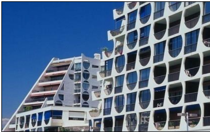
Figure 41 : les ouvertures orientées vers la mer. La grande motte France
