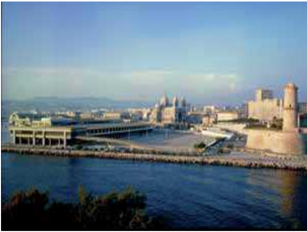
Figure 60: avant : le hangar J4 en 1997
