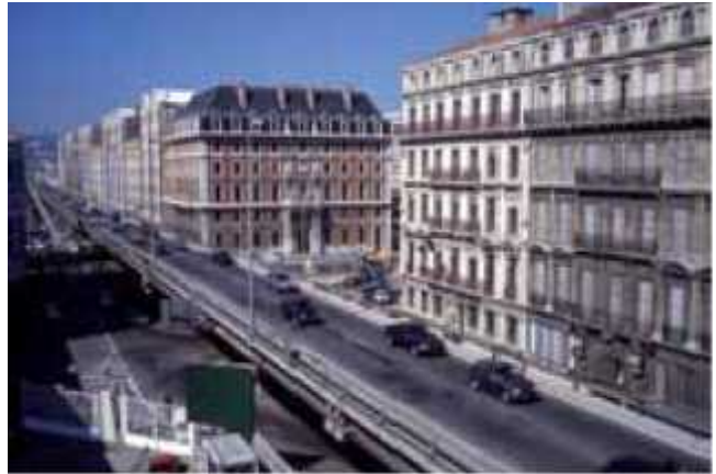
Figure 50: Le viaduc de La Joliette avant sa démolition
