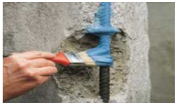
Figure 18: Utilisation de peinture hydrofuge contre la corrosion
