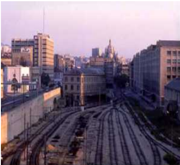
Figure 59: avant : la gare des Doc ks avant les travaux de construction du quartier d'affaires
