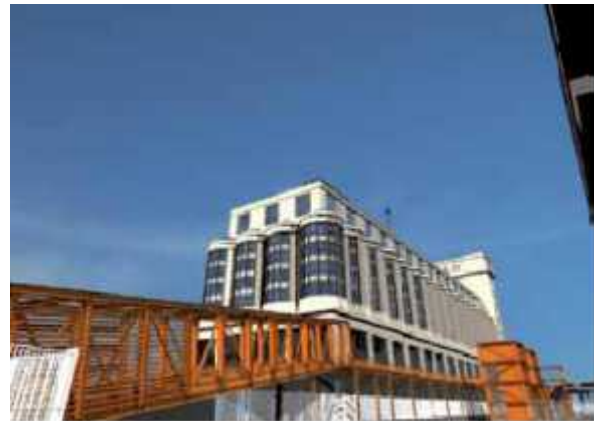
Figure 62: après : sa transformation en salle de spectacles
