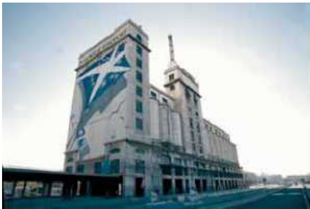
Figure 63: avant : Le silo à grain d'Arenc
