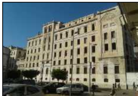
Figure II.3-1 bâtiments industriels en état de friche (la minoterie Narbonne d'Hussein dey). Source : travail d'atelier.
