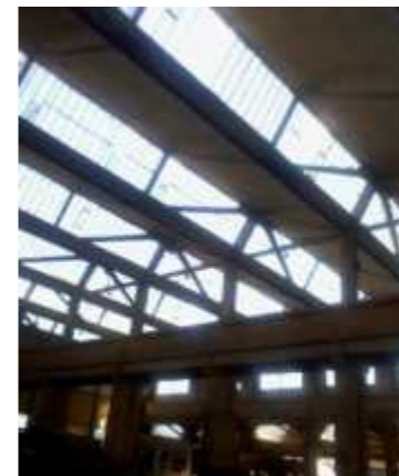
Figure II.15-3: éclairage zénithal les sheds. Source : auteur.
