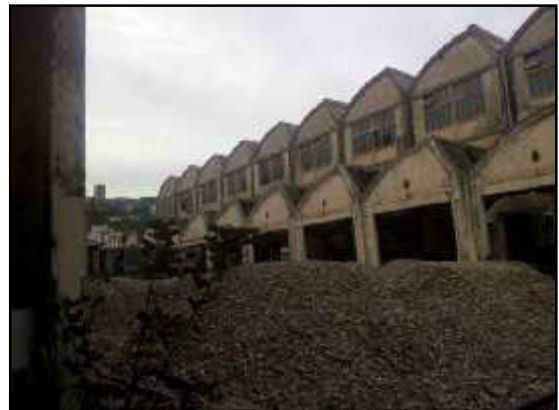
Figure II.3-2: bâtiment industriel en sheds (atelier de maintenance d'El Hamma). Source : prise par l'auteur.
