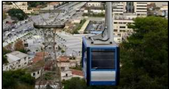
Figure II.11-20: ligne téléphérique. Source :Google image.
