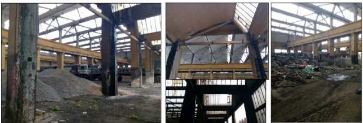
Figure 1: état de fait bloc A . Source auteur .
