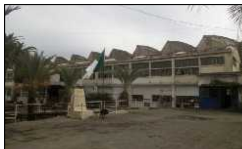
Figure II.11-25 les ateliers des SNTF. Source : prise par l'auteur.
