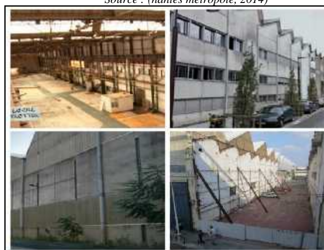
Figure II.5-4: intérieur et extérieur des halles d'Alstom . Source : (Les Halles Alstom une réhabilitation au cœur du quartier)
