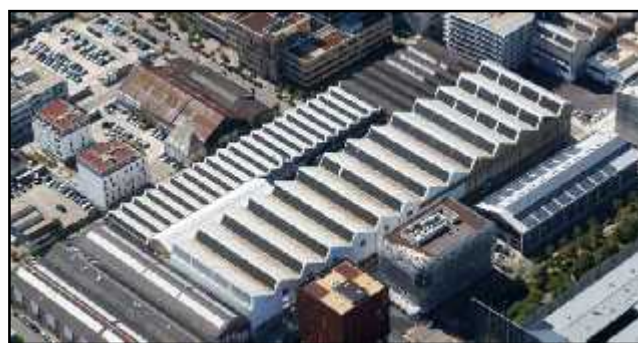
Figure II.5-3: les halles d'astome avant la transformation. Source : (nantes métropole, 2014)
