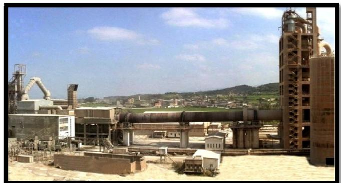
Figure I.9 : Ligne de cuisson d'une cimenterie
