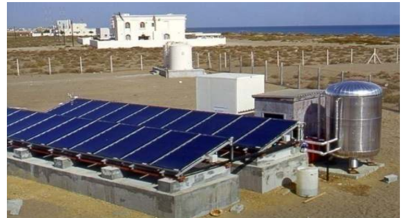
Figure 1.6 : Dessalement par distillation alimentée par chauffe-eau solaire [17]
