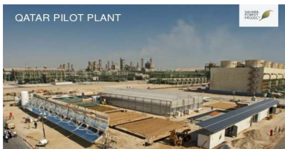
Figure 1.7: Dessalement par distillation alimentée par concentration solaire Qatar 2012 [18].
