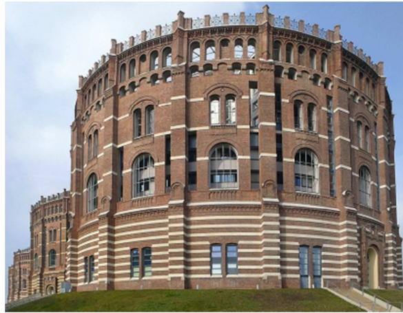
Figure 17: les quatre gazomètres de vienne, source : Reconversions. L'architecture industrielle réinventée Emmanuelle Real
