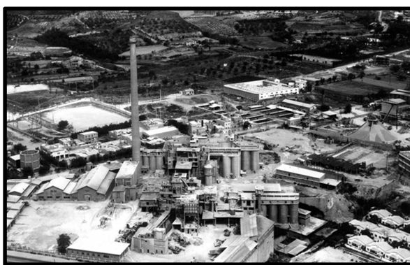
Figure 99 : vue aérienne de la fabrica avant l'intervention de Ricardo Bofill, source : Taller de Arquitectura ou la fabrica - Ricardobofill
