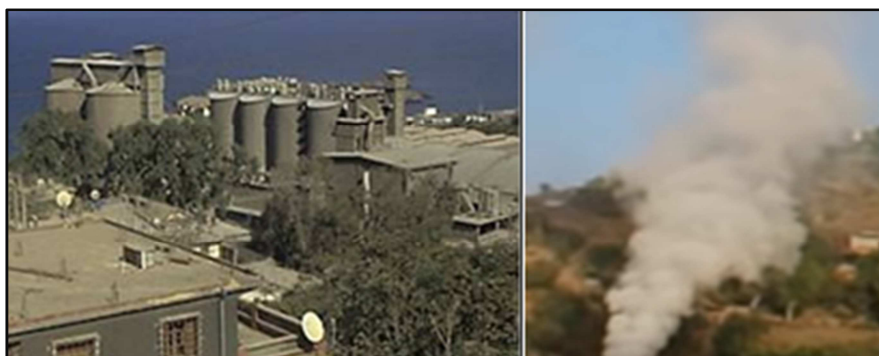
Figure 35: nuisance de la cimenterie par rapport à son environnement, source: auteur
