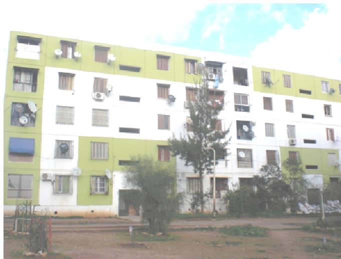
Photo 16: Vue sur les espaces extérieurs de l'habitat collectif (Cité 350logts) Source :photo prise par l'auteur.
