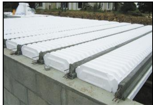
Figure III. 42 : dalle corps creux avec hourdis en polystyrène
