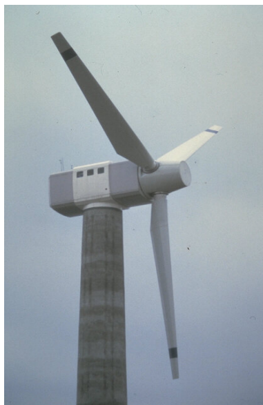
(a) Eolienne upwind de 750kW ( www.afm.dtu.dk/wind/turbines )
