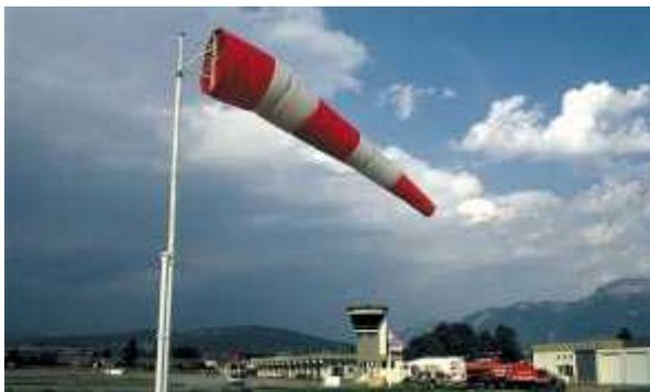
L'aire de mouvement d'un aéroport doit être équipée d'au moins une manche à vent.
