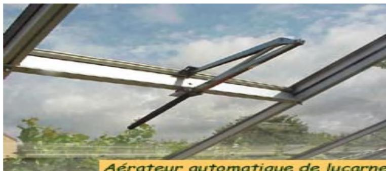
Figure 1.14 : Système d'aération automatique (Compas).
