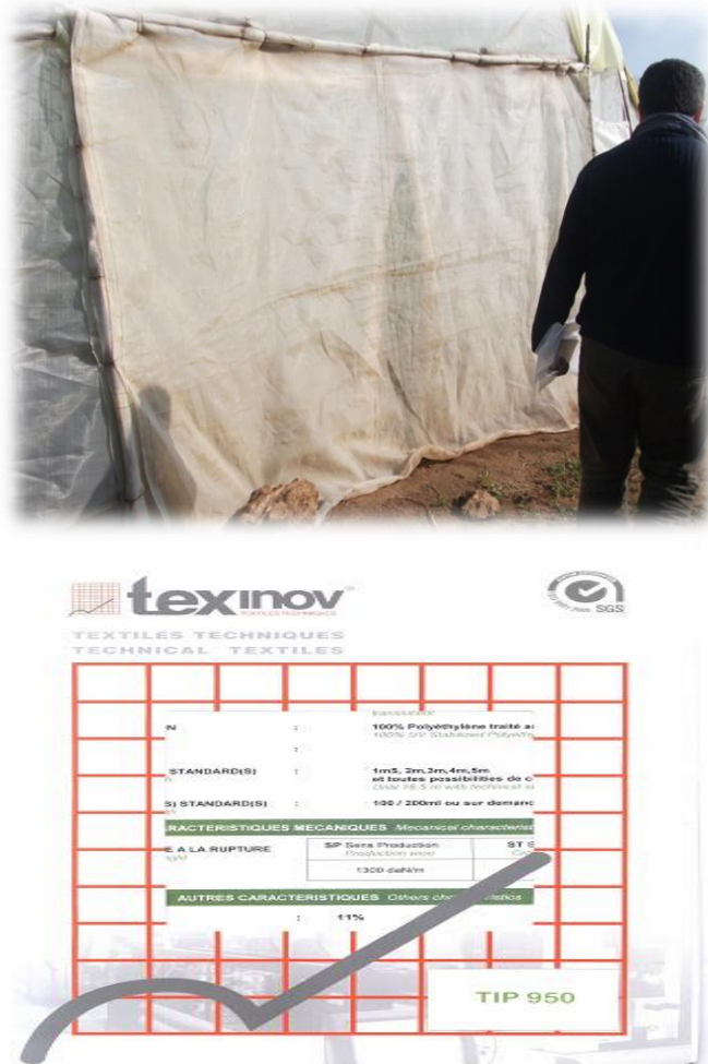
Figure 3.12. - Serre protégée par filet Insect-Proof (photographies originales)
