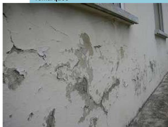
Image 67: Impacte de l'humidité sur les murs
