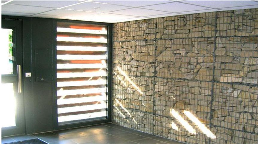
Figure 32 : Mur en gabion à l'intérieur de la maison entièrement nu
