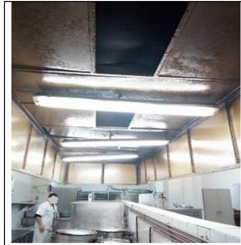
-Photo n° (21) : dimension réduite, avec un fumer excessif du a la panne de hotte aspirante. (pp).
