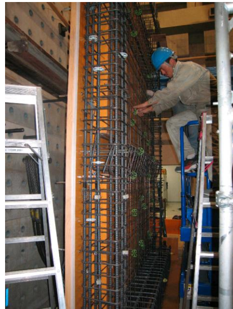
(b) Ferrailages panneaux de voile
