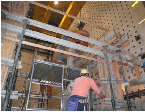
(c) Coffrage et coulage du béton
