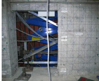
(b) Fissures de cisaillement dans le panneau de voile du 1 er niveau
