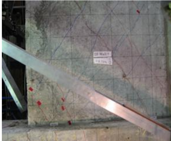
(a) Fissures de cisaillement dans le panneau de voile du 2 ème niveau
