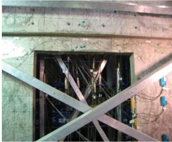
(b) Fissures de cisaillement dans le panneau de voile du 1 er niveau
