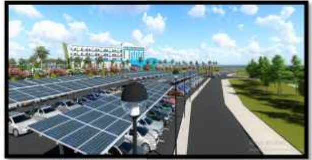
Figure III.6: panneaux photovoltaïque au niveau des abris des parkings source: Auteur.
