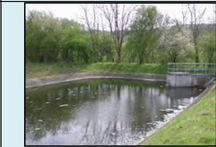
Figure 81 : bassin de récupération des eaux pluviales Source: https://www.youtube.com/watch?v=t6id2-zYUmM
