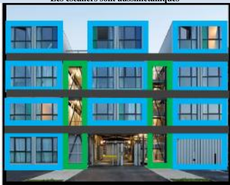
Les escaliers sont aussi métalliques
